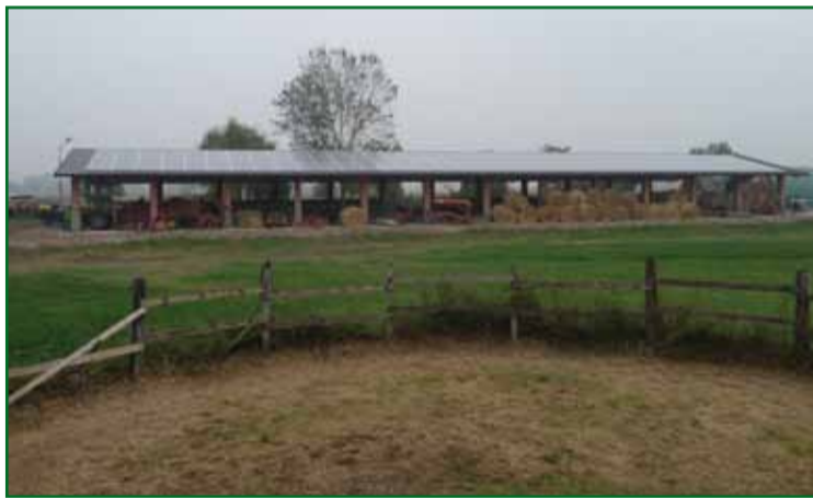
la stalla con copertura fotovoltaica
