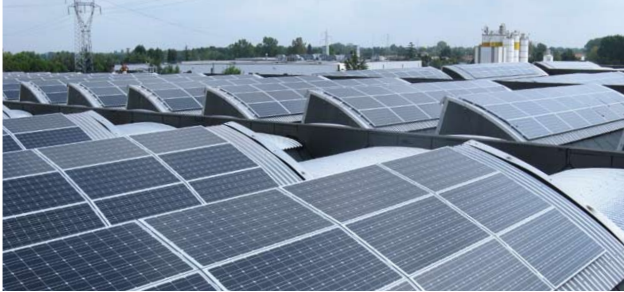
Impianto realizzato da SolarElit su lucernari curvilinei in provincia di Venezia
