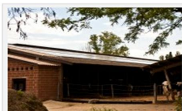
scorcio dell'impianto fotovoltaico sulle stalle
